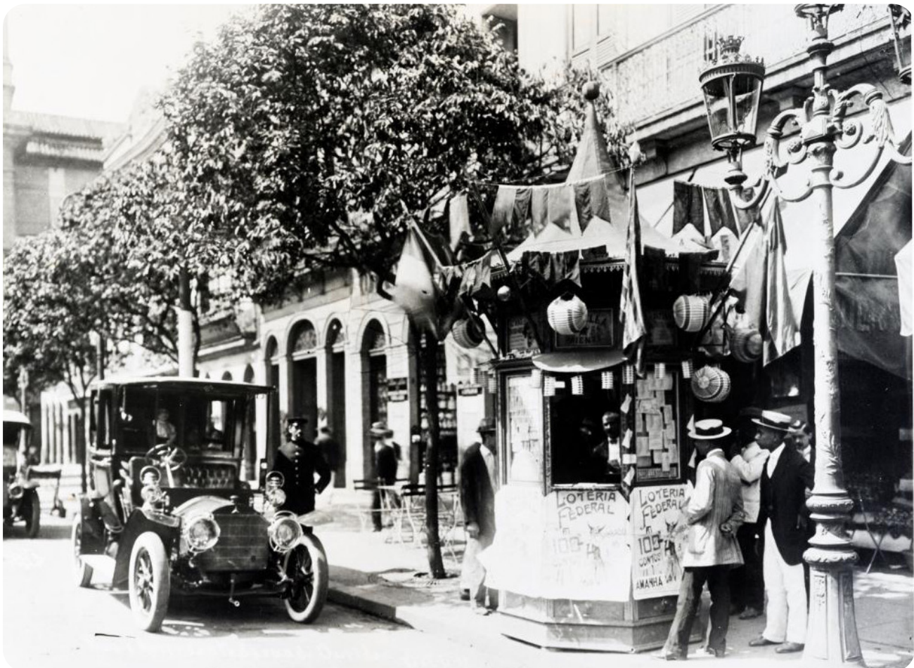
Rua Primeiro de Março, na altura da Rua do Ouvidor, 1911 Foto: Malta, Augusto / Instituto Moreira Salles
